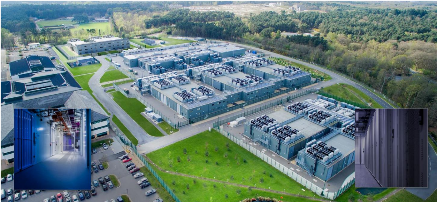
Qnetix UK Datacentre
